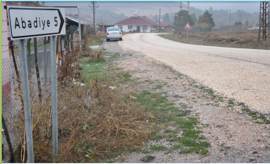
MERKEZ-ABADIYE I.KAT ve II.KAT ASFALT
