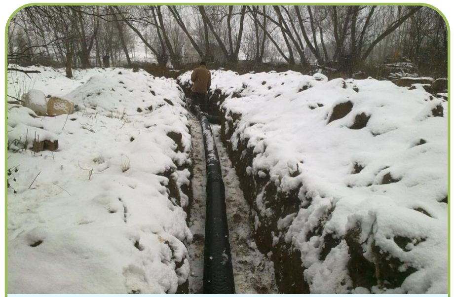
SÖĞÜT OLUKLU KANALİZASYON
