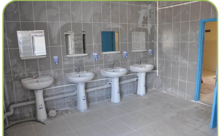
SÖĞÜT ERTUĞRULGAZİ ORTAOKULU ISLAK MEKAN TADİLATLARI
