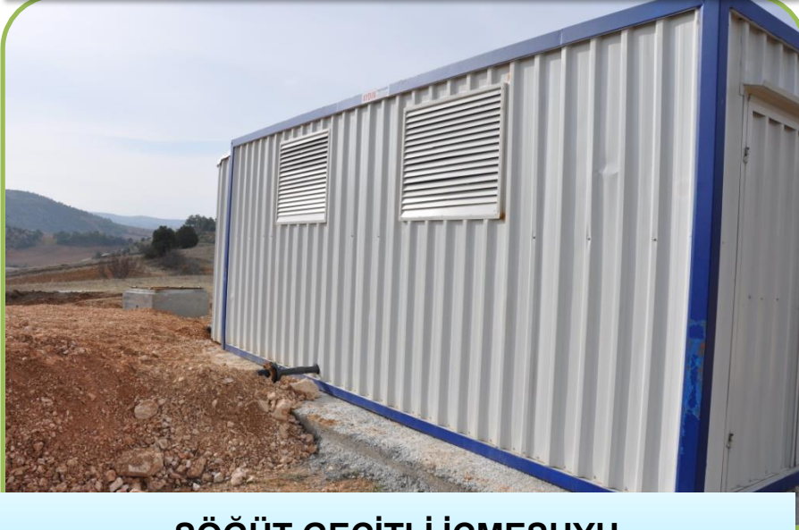
SÖĞÜT GEÇİTLİ İÇMESUYU ARSENİK ARITMA TESİSİ
