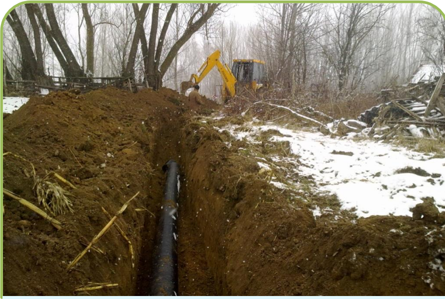
SÖĞÜT OLUKLU KANALİZASYON
