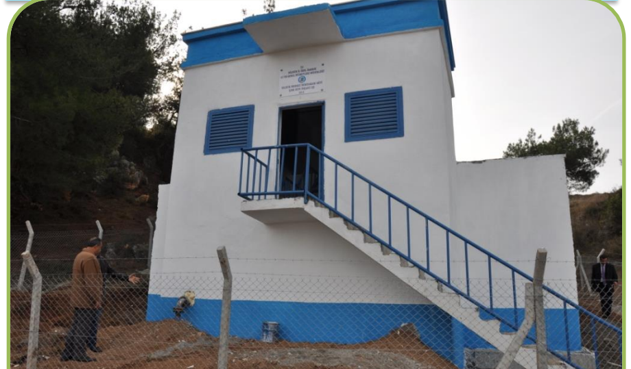
MERKEZ DERESAKARYA İÇMESUYU YENİ DEPO YAPIMI
