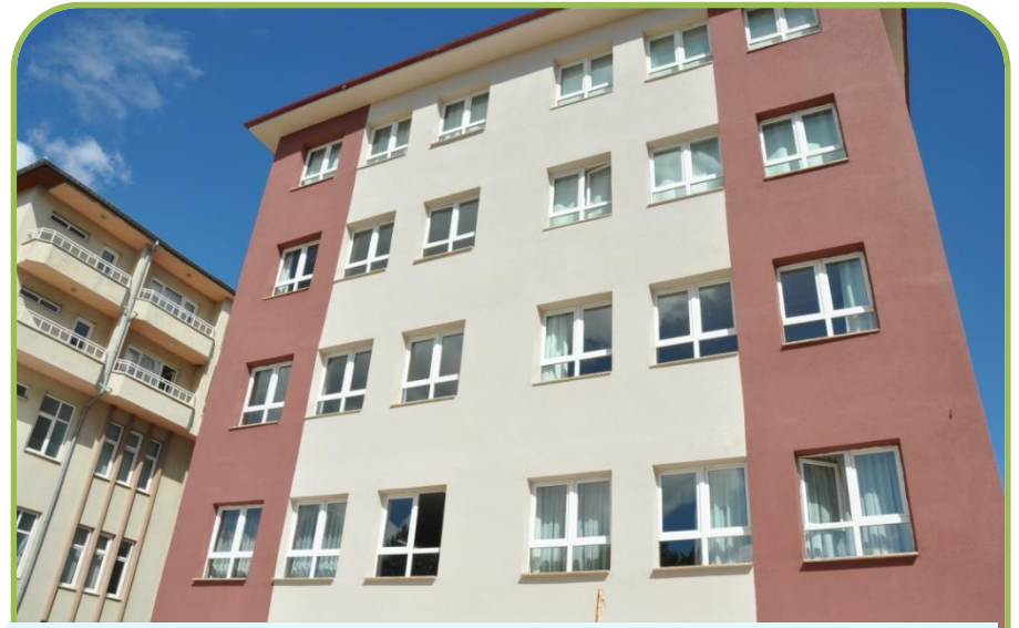
BOZÜYÜK ŞEHİT ZAFER İPEK ÖZEL EĞİTİM OKULU MANTOLAMA İŞİ
