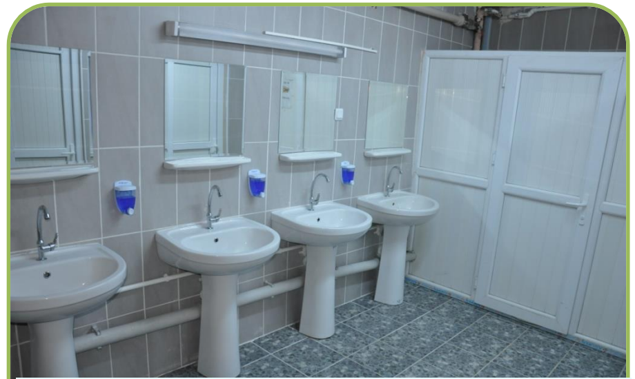
MERKEZ BAYIRKÖY İLK ve ORTA OKULU ISLAK MEKAN TADİLATLARI
