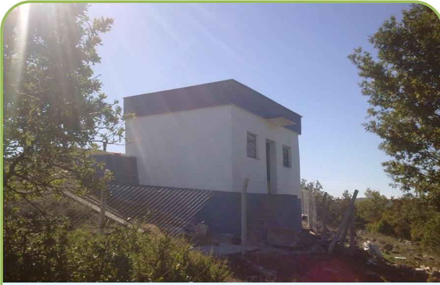
MERKEZ ÇAKIRPINAR İÇMESUYU DEPO ONARIMI
