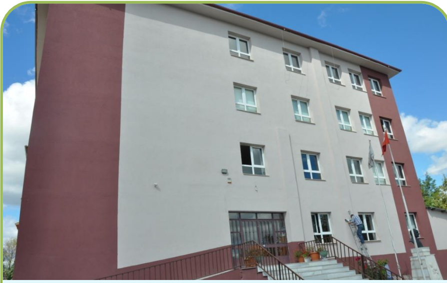
BOZÜYÜK ŞEHİT ZAFER İPEK ÖZEL EĞİTİM OKULU MANTOLAMA İŞİ
