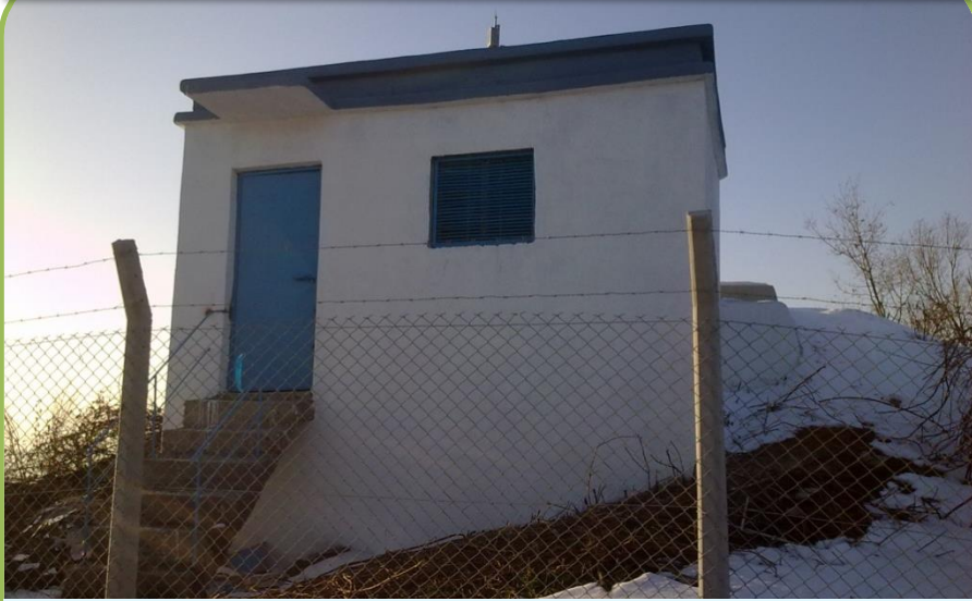
BOZÜYÜK-KIZILTEPE İÇMESUYU DEPO ONARIMI
