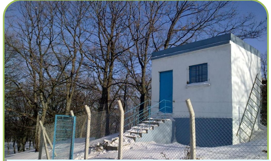
BOZÜYÜK-HAMİDİYE İÇMESUYU DEPO ONARIMI
