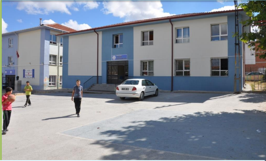
BOZÜYÜK ZAFER ORTAOKULU MANTOLAMA İŞİ
