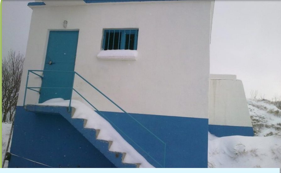
GÖLPAZARI KÜMBET İÇMESUYU DEPO ONARIMI
