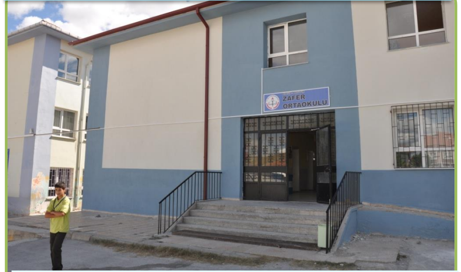
BOZÜYÜK ZAFER ORTAOKULU MANTOLAMA İŞİ
