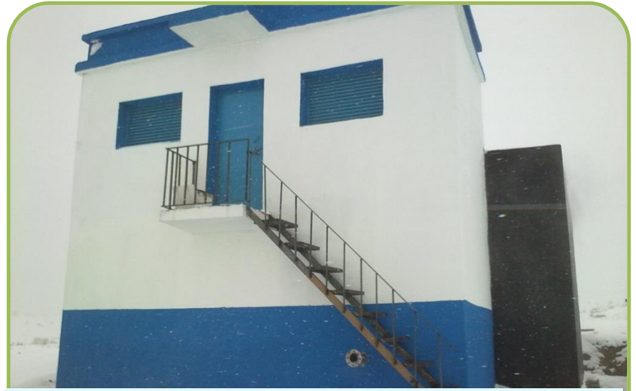
SÖĞÜT OLUKLU İÇMESUYU DEPO ONARIMI
