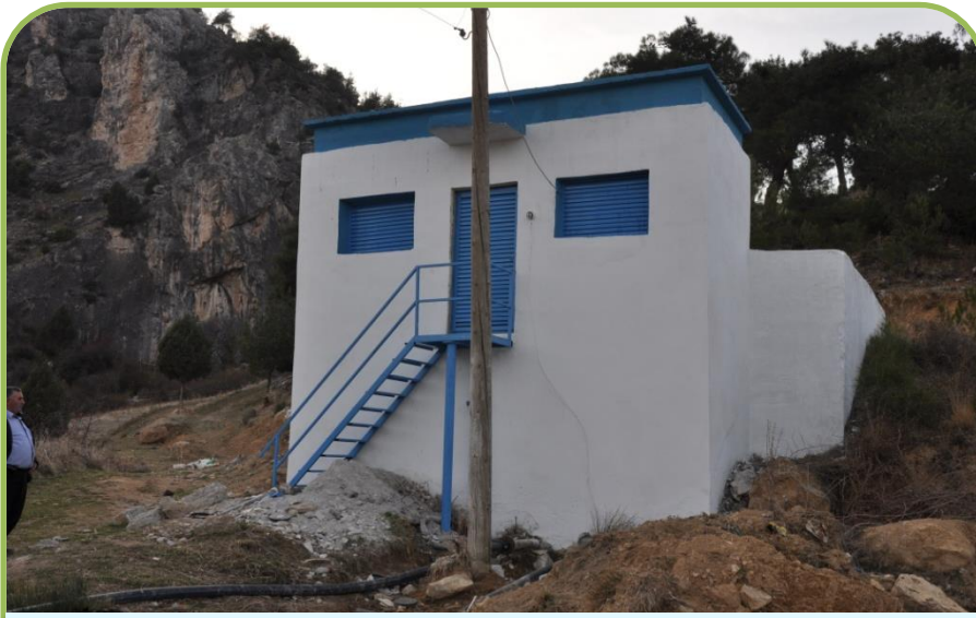
İNHİSAR SAMRI İÇMESUYU DEPO ONARIMI
