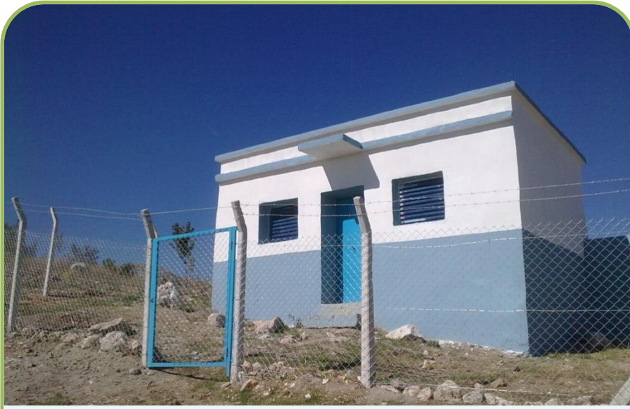
GÖLPAZARI BÜYÜKBELEN İÇMESUYU DEPO ONARIMI
