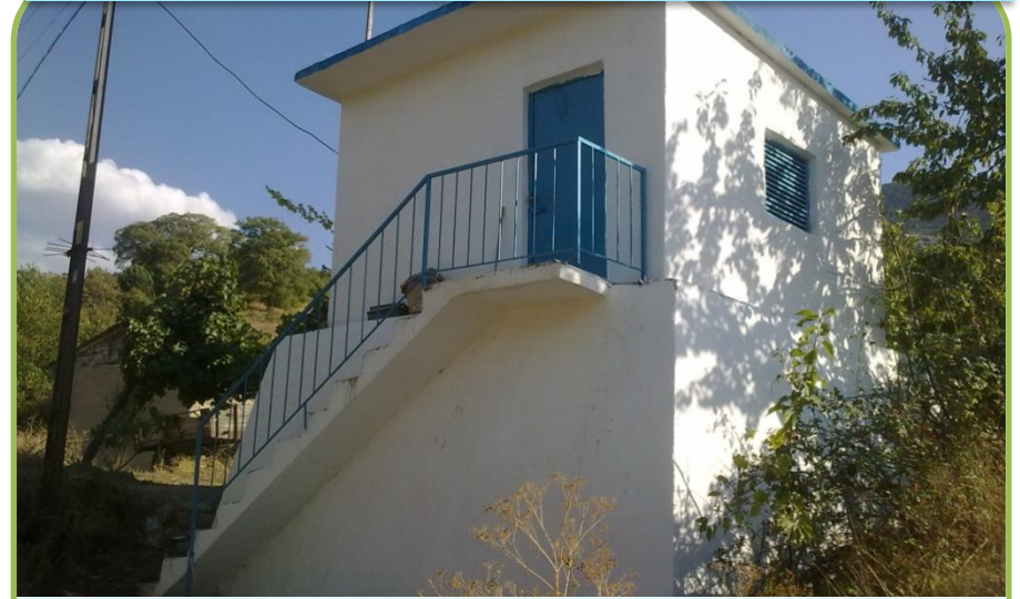
GÖLPAZARI BAYAT İÇMESUYU DEPO ONARIMI
