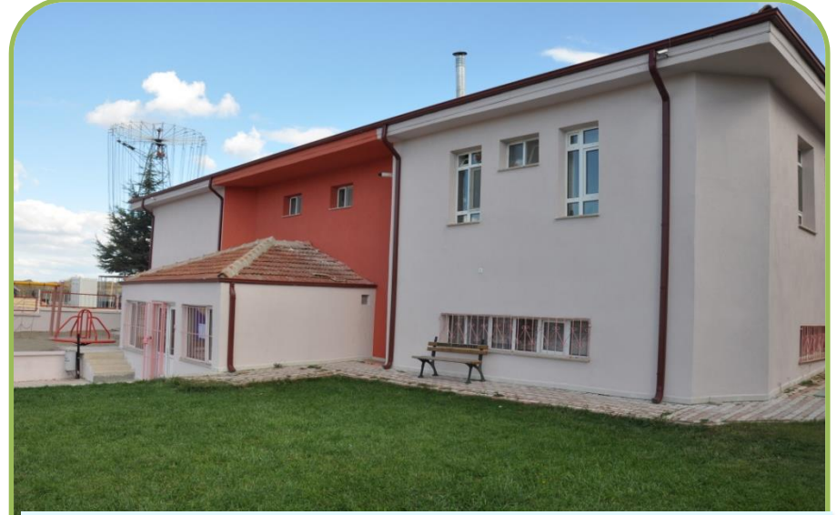
SÖĞÜT 75.YIL ANAOKULU MANTOLAMA İŞİ
