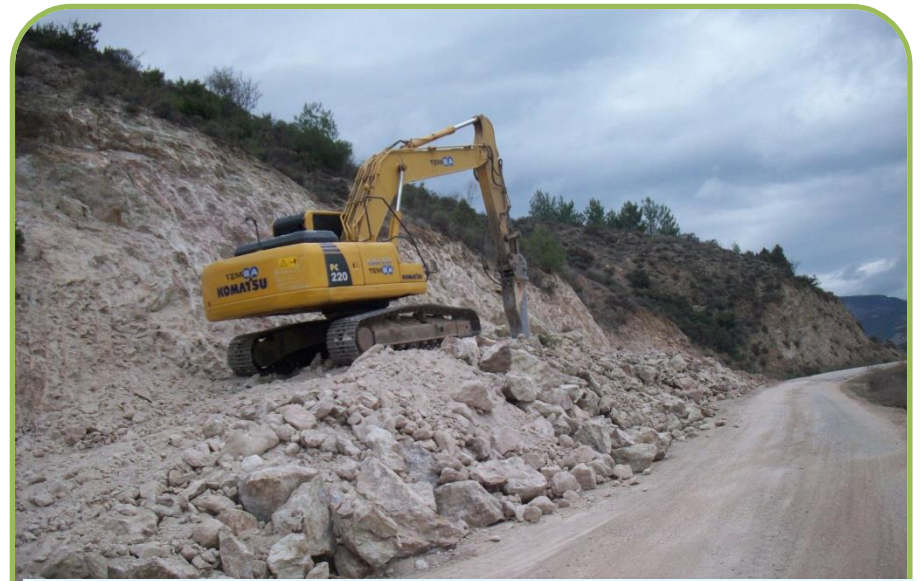
SÖĞÜT-ÇALTI HAMİTABAT I.KAT ASFALT
