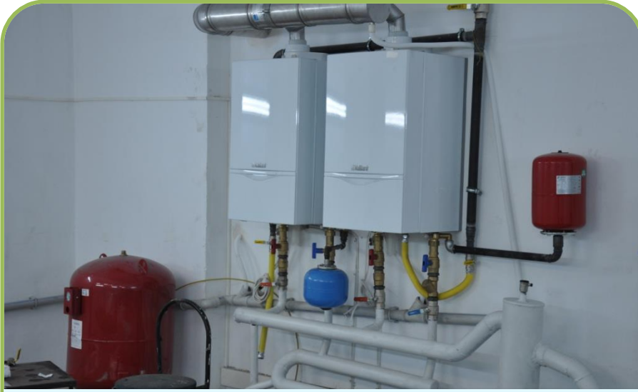
OSMANELİ-HALK KÜTÜPHANESİ DOĞALGAZ DÖNÜŞÜM İŞİ
