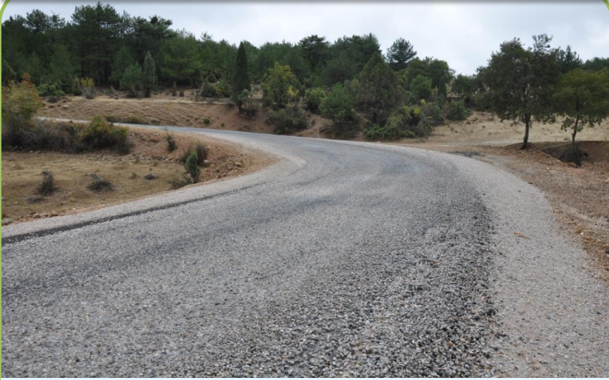
SÖĞÜT-BORÇAK I.KAT ASFALT
