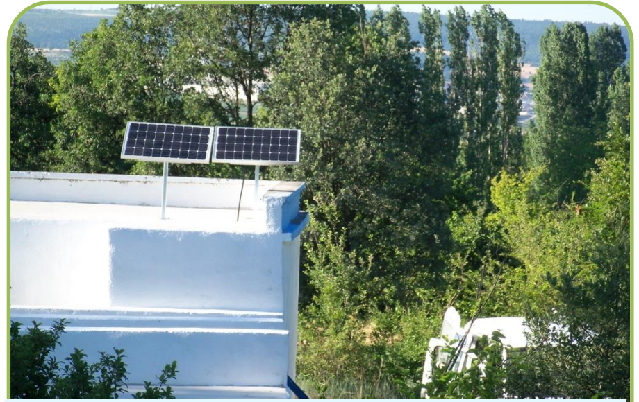
MERKEZ GÖKPINAR İÇMESUYU DEPO ONARIMI
