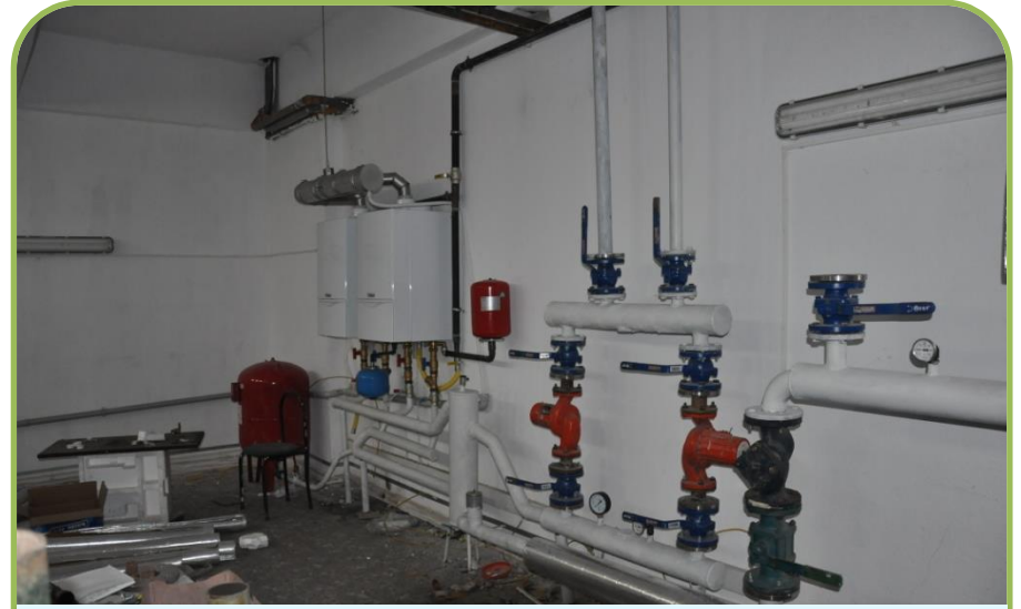
OSMANELİ-HALK KÜTÜPHANESİ DOĞALGAZ DÖNÜŞÜM İŞİ
