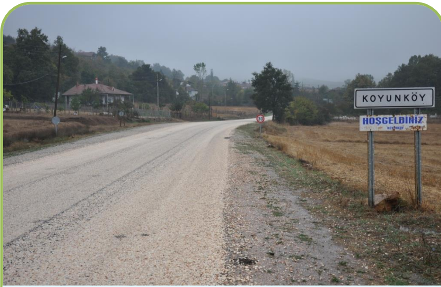
MERKEZ-KOYUNKÖY-BAHÇECİK I.KAT ve II.KAT ASFALT
