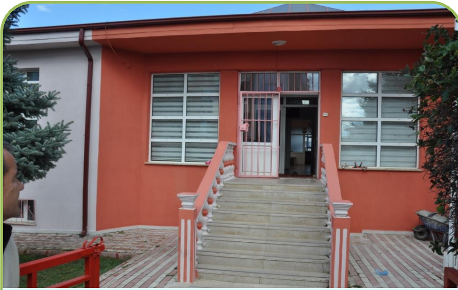
SÖĞÜT 75.YIL ANAOKULU MANTOLAMA İŞİ
