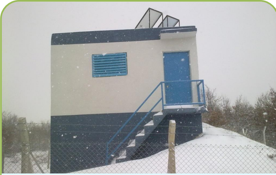
BOZÜYÜK-DARIDERE İÇMESUYU DEPO ONARIMI
