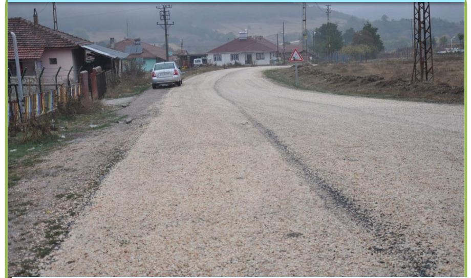
MERKEZ-ABADIYE I.KAT ve II.KAT ASFALT
