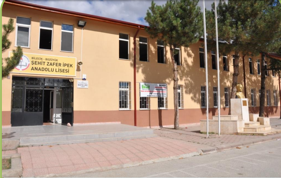
BOZÜYÜK ŞEHİT ZAFER İPEK ANADOLU LİSESİ MANTOLAMA İŞİ
