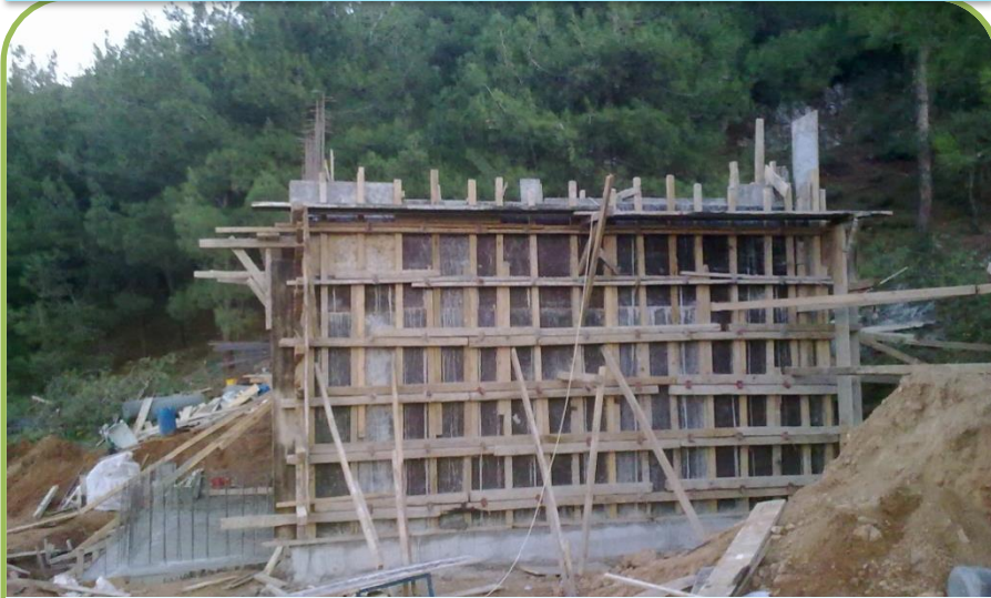
MERKEZ DERESAKARYA İÇMESUYU YENİ DEPO YAPIMI
