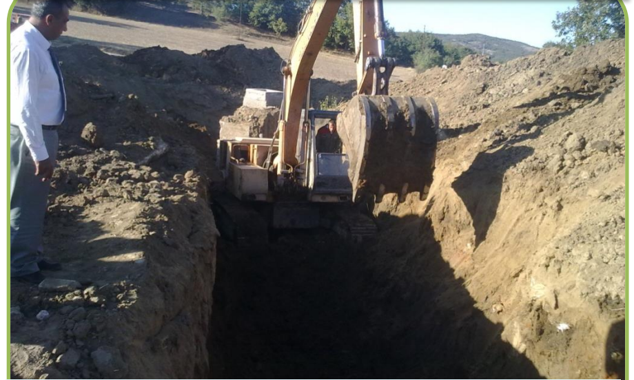
BOZÜYÜK-KIZILTEPE İÇMESUYU DRENAJ
