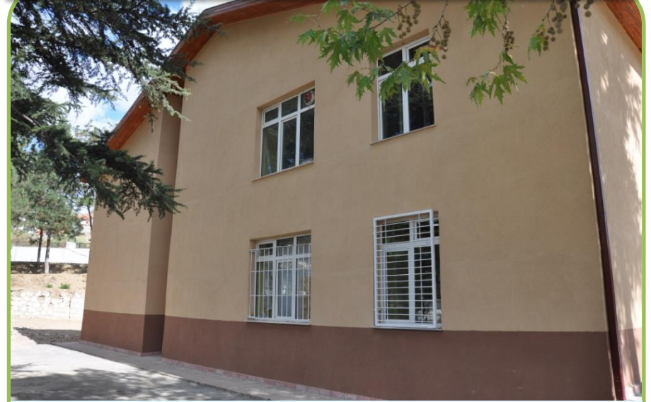
BOZÜYÜK ŞEHİT ZAFER İPEK ANADOLU LİSESİ MANTOLAMA İŞİ
