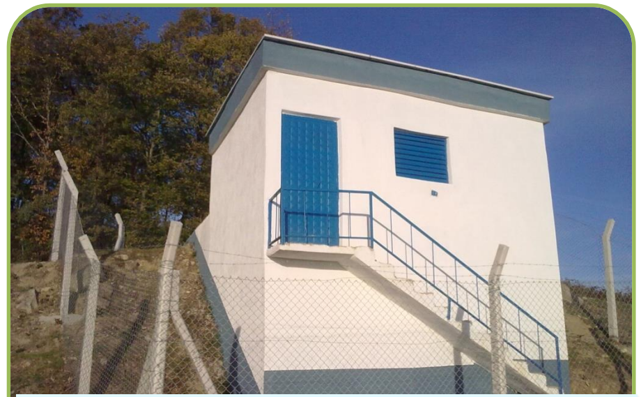
GÖLPAZARI AKÇAKAVAK İÇMESUYU DEPO ONARIMI
