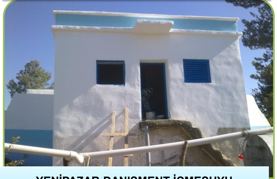
YENİPAZAR DANIŞMENT İÇMESUYU DEPO ONARIMI
