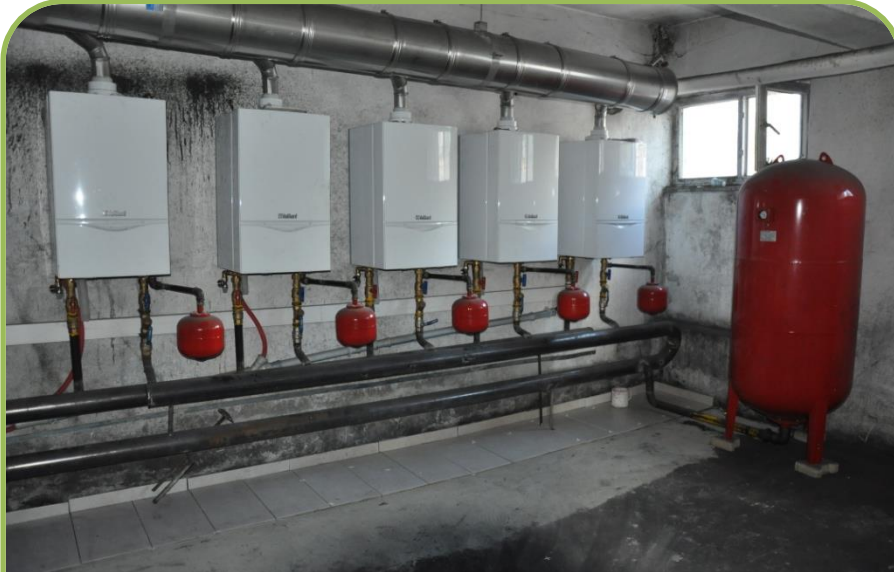
SÖĞÜT ERTUĞRULGAZİ ORTAOKULU DOĞALGAZ DÖNÜŞÜM İŞİ
