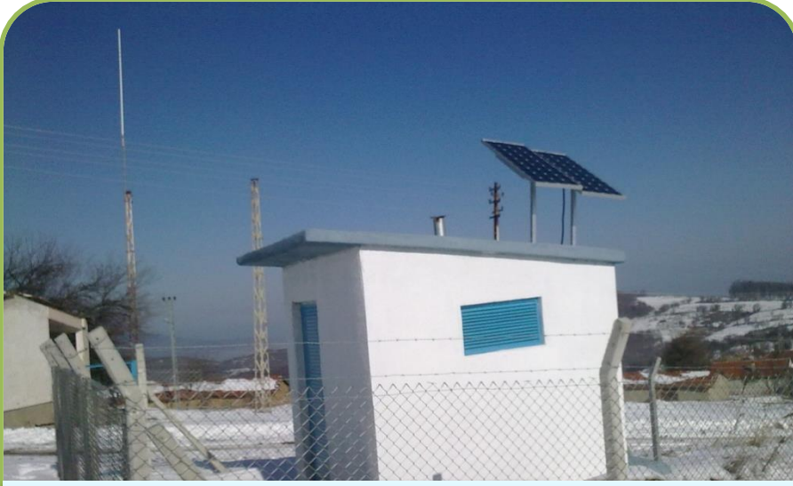
BOZÜYÜK-ÇAMYAYLA İÇMESUYU DEPO ONARIMI
