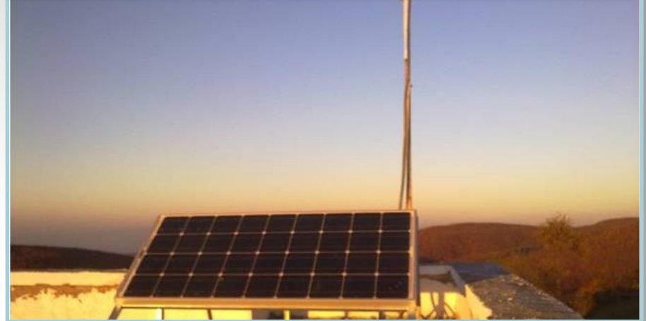
Merkez-İkizce Köyü Aktarmalı Telsiz Sinyalli Şamandıra ve Güneş Enerjili Klorklama Cihazı
