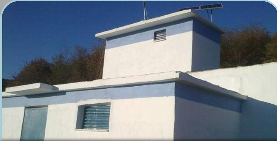
Merkez-Kendirli İçmesuyu Depo Onarımı
