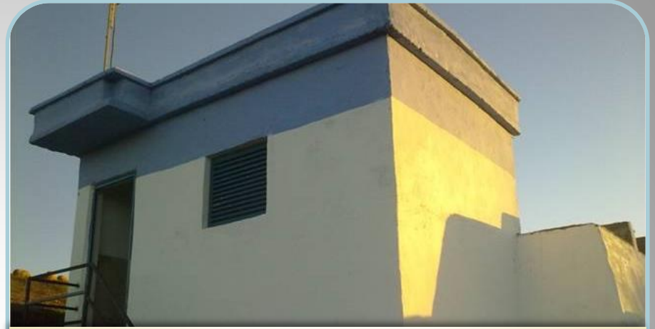
Merkez-İkizce İçmesuyu Depo Onarımı
