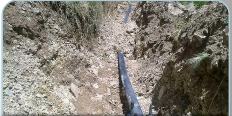
Merkez-Selöz Köyü İçmesuyu İsale Hattı Yapımı
