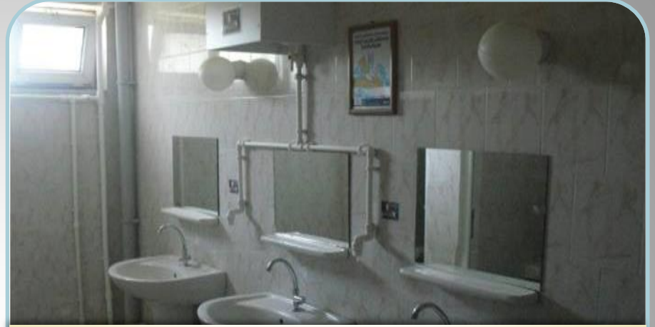
Bozüyük Çitosan İlköğretim Okulu Islak Mekan Tadilatları
