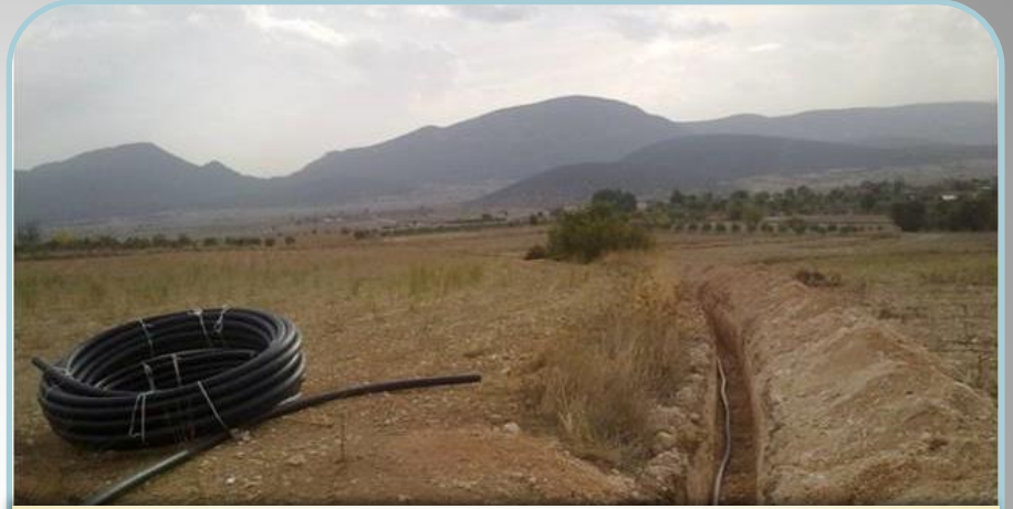
Pazaryeri-Demirköy Köyü İçmesuyu İsale Hattı Yapımı
