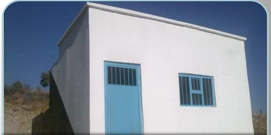
Gölpazarı-Aktaş Köyü Beşevler Mah.Yeni İçmesuyu Gömme Depo Yapımı
