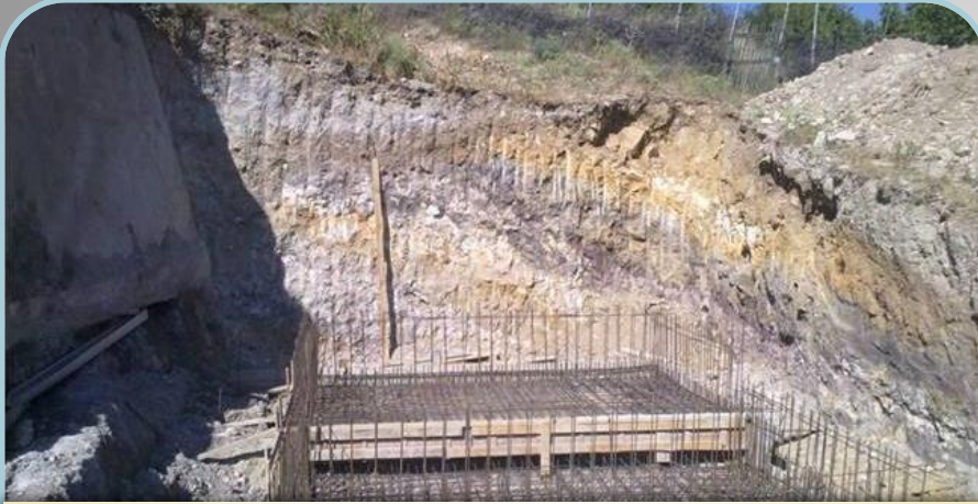
Gölpazarı-Aktaş Köyü Beşevler Mah.Yeni İçmesuyu Gömme Depo Yapımı
