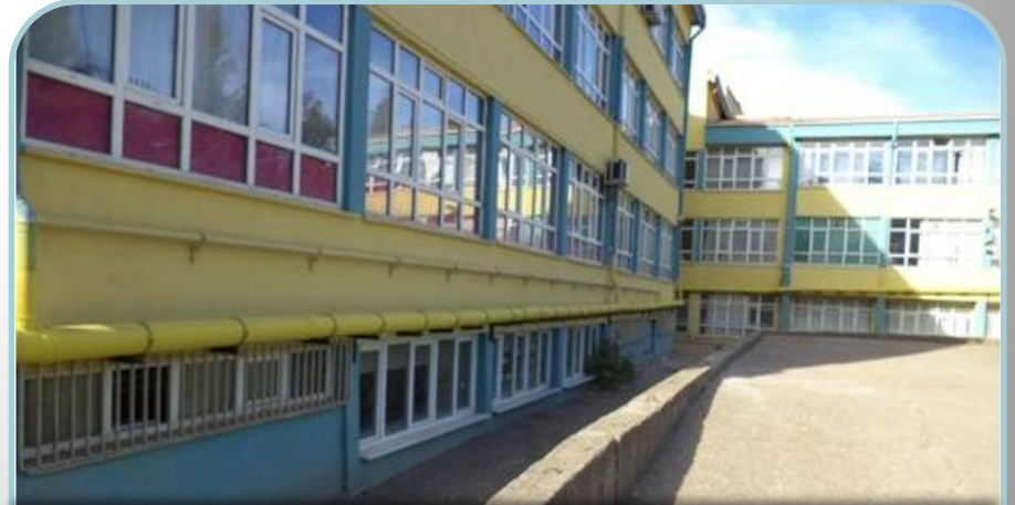
Merkez Osmangazi İlköğretim Okulu (Yağmur Suyu Hattı ve Islak Mekan Onarımları)
