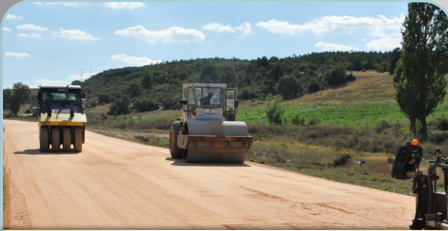
Pelitözü Gölpark Yol Çalışmaları
