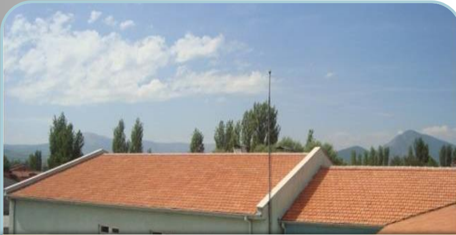
Gölpazarı Devlet Hastanesi Çatı Onarım işi
