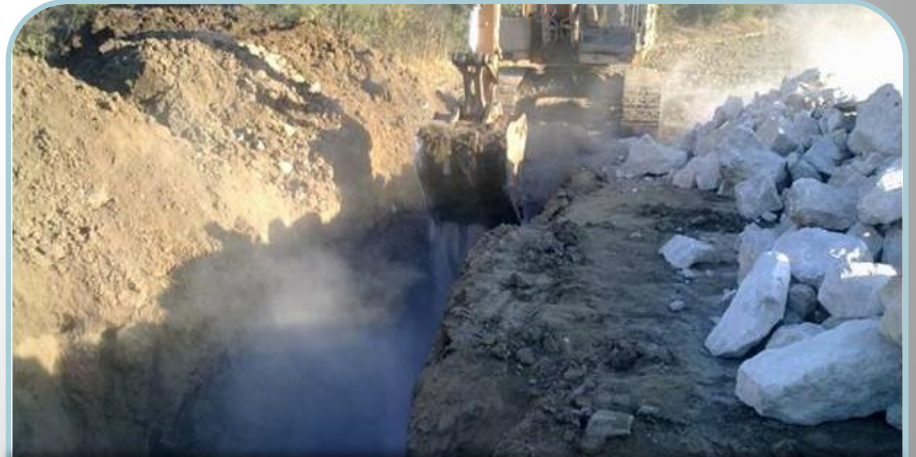
Bozüyük-Kızıltepe Köyü Drenaj Çalışması
