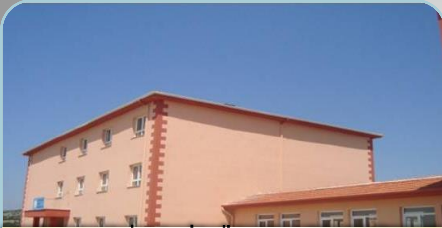
Bozüyük İçköy İlk Öğretim Okulu (Dış cephe Mantolama ve Islak Mekan Tadilatı)
