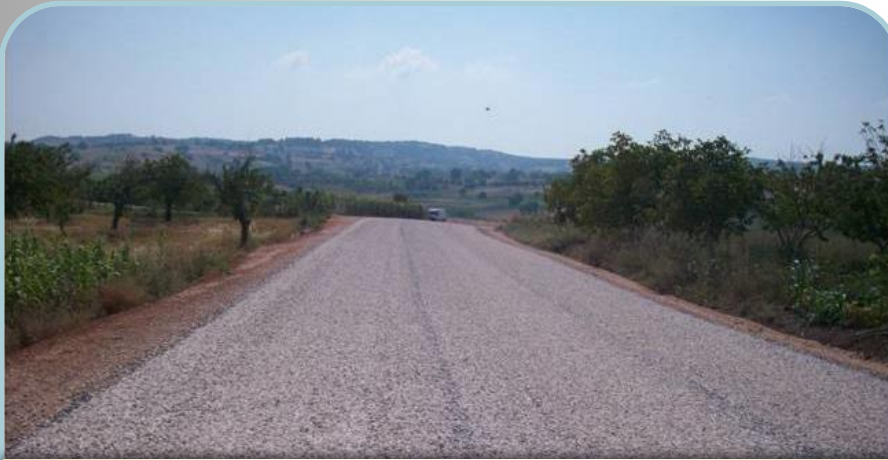
Merkez-İlyasbey Köyü Asfalt Yapımı
