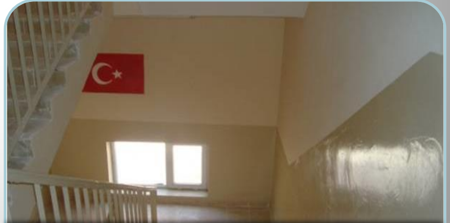
Osmaneli Hisarcık Köyü Beşevler İlköğretim Okulu İç cephe boya, Islak Mekan Tadilatı
