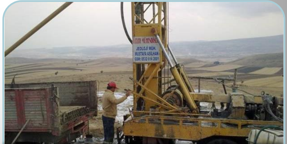
Söğüt-Geçitli Köyü Sondaj Çalışması
