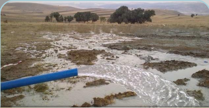
Pazaryeri-Fıranlar Köyü İsale Hattı Yapımı
