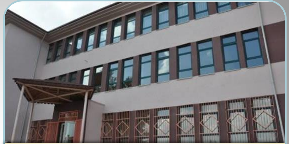
Bozüyük Fen Lisesi Dış cephe Mantolama, Elektrik ve Mekanik Tesisatı Onarımı İç cephe boya döşeme kaplaması değişimi , ıslak mekan tadilatları
