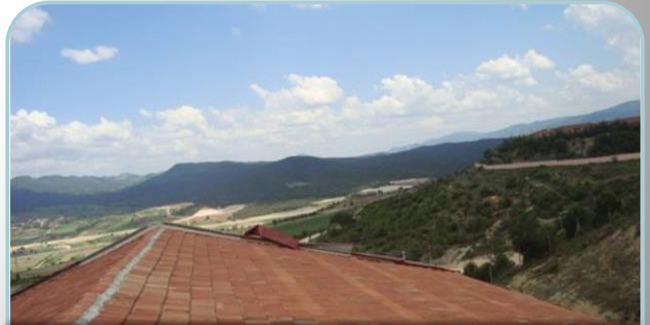
Osmaneli Ticaret Meslek Lisesi Çatı onarımı ve ıslak mekan tadilatları
