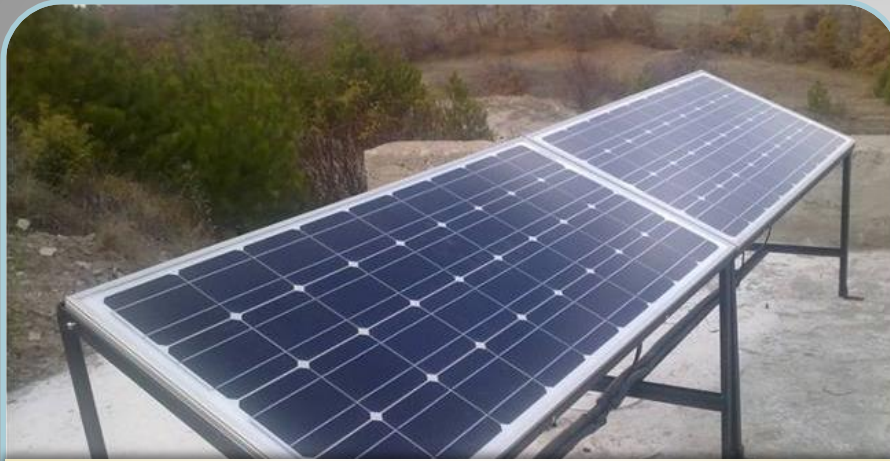
Bozüyük-Ketenlik Köyü Güneş Enerjili Klorklama Cihazı
