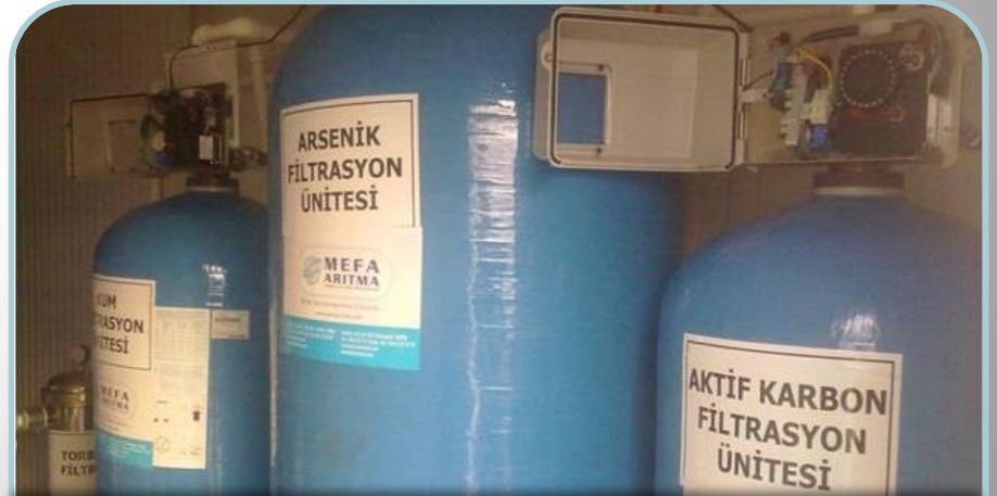
Yenipazar-Kösüre Köyü Arsenik Arıtma Tesisİ
