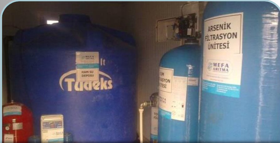
Yenipazar-Kösüre Köyü Arsenik Arıtma Tesisİ
