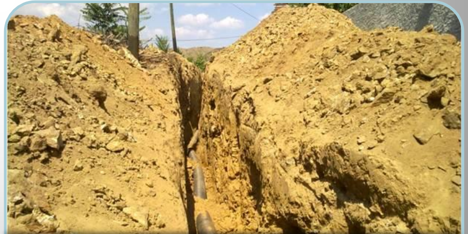
Merkez-Yeniköy Kanalizasyon Çalışması
