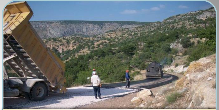
İnhisar-Harmanköy Yol Çalışması
