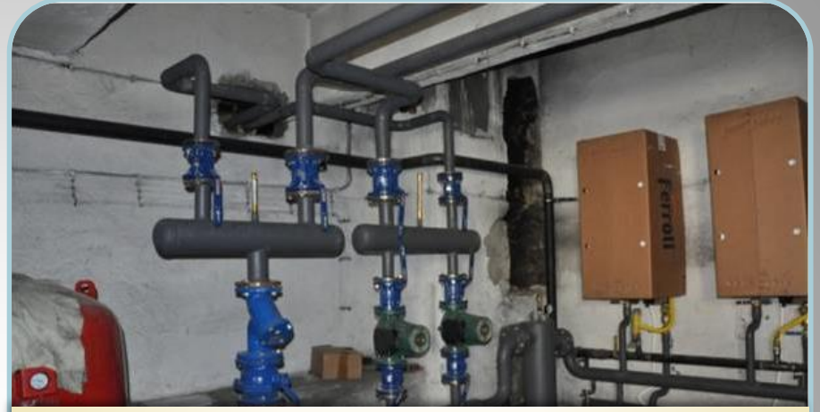
Söğüt Ayşe Küflü İlköğretim Okulu Doğalgaz Dönüşüm İşi ve Islak Mekan Tadilatları
