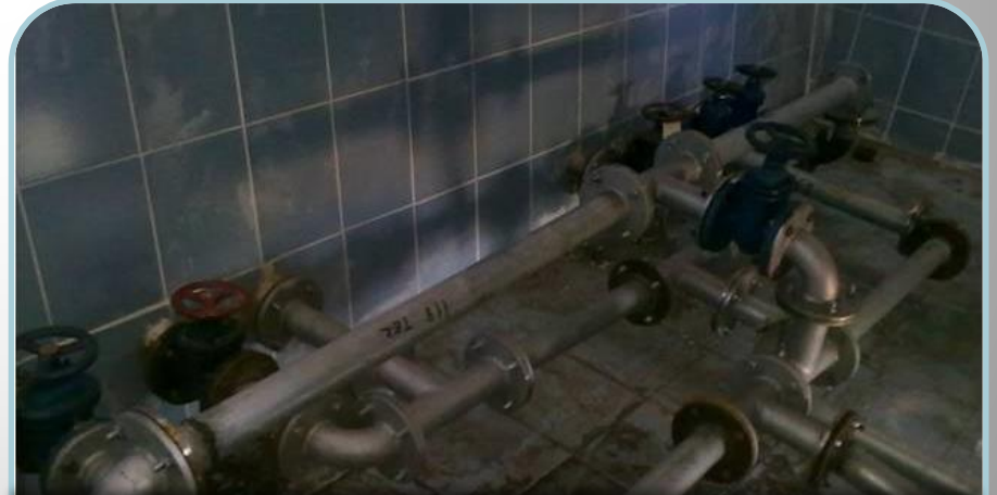
Söğüt-Ortaca İçmesuyu Depo Onarımı
