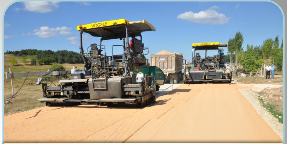
Pelitözü Gölpark Yol Çalışmaları
