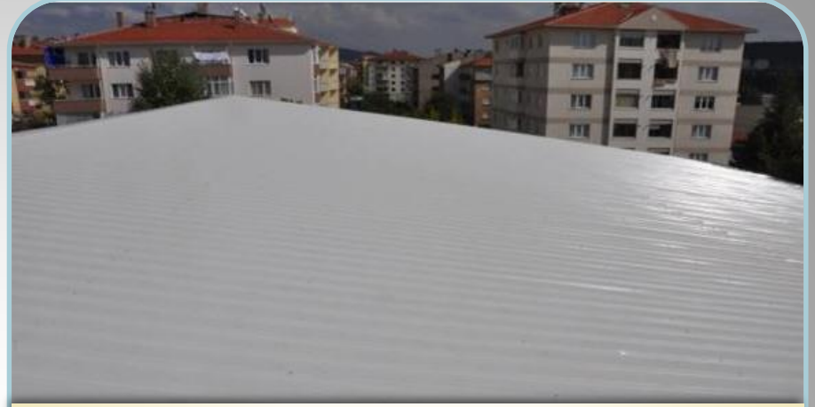
Bozüyük Endüstri Meslek Lisesi Çatı Onarımı ve Doğalgaz Dönüşüm İşİ
