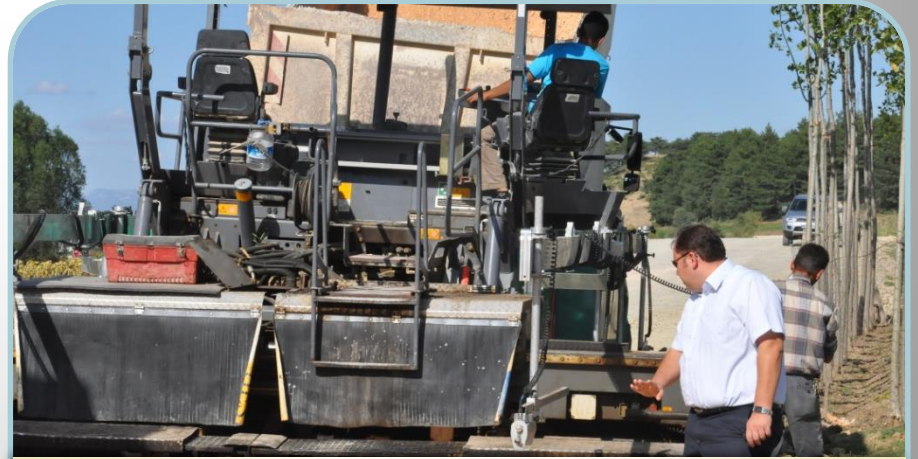
Pelitözü Gölpark Yol Çalışmaları
