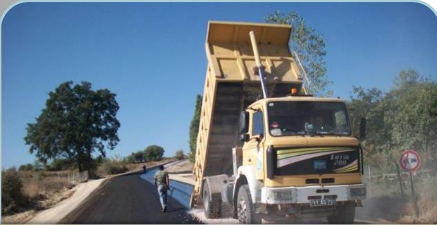
Merkez-Dereşemsettin-Kendirli Yol Çalışması
