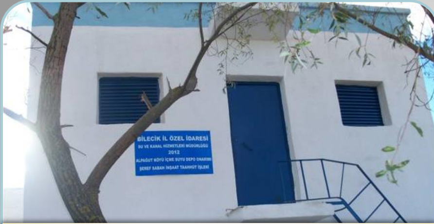
Merkez-Alpagut İçmesuyu Depo Onarımı
