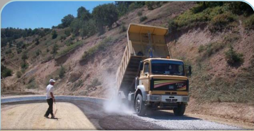
Söğüt-Ortaca-Uludere Yol Çalışması
