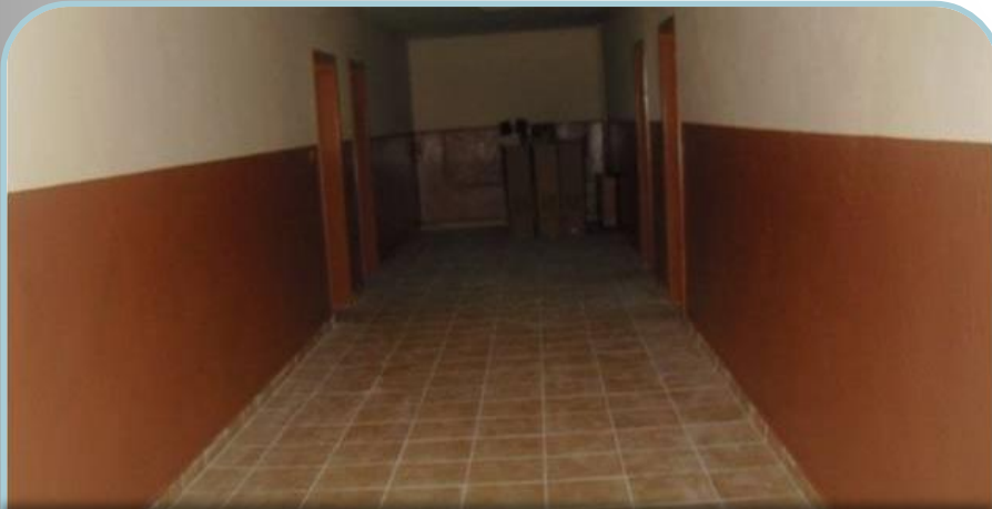
Gölpazarı İmam Hatip Lisesi İç cephe boya, döşeme kaplaması değişim İşleri
