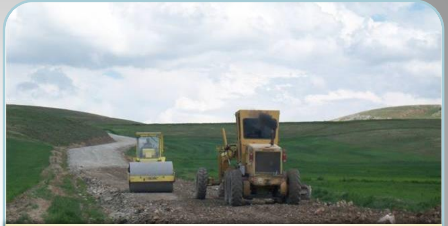
Söğüt-Ortaca-Yeşilyurt Yol Çalışması
