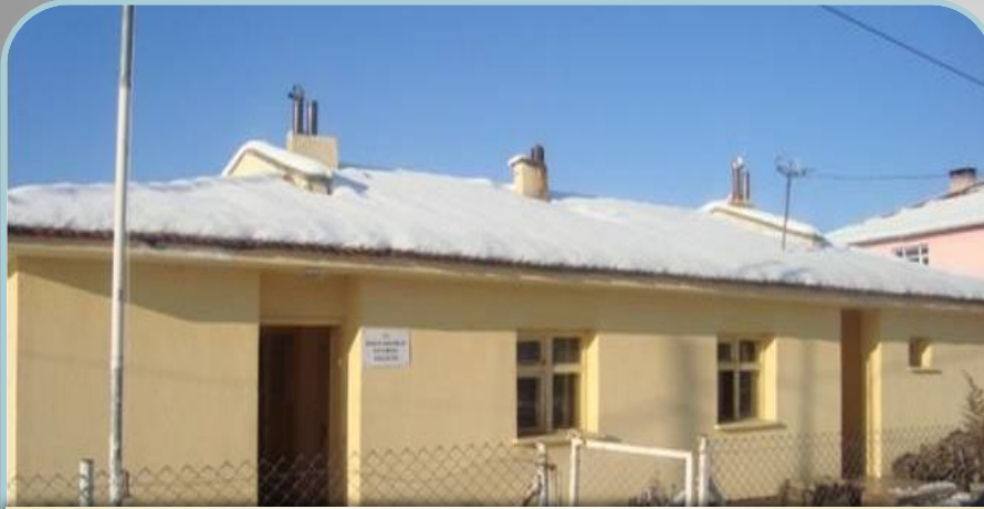
Merkez Koyunköy Sağlık Evi Çatı onarım işi, ıslak mekan tadilatı,dış cephe boya işleri
