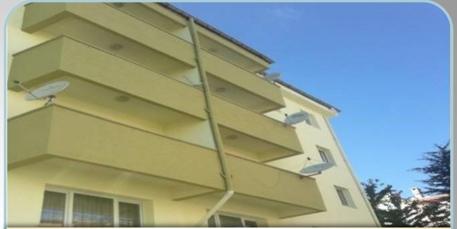
Söğüt İlçe Emniyet Müdürlüğü Dış cephe mantolama işi
