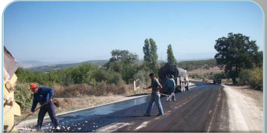
Merkez-Dereşemsettin-Kendirli Yol Çalışması
