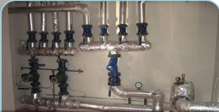
Osmaneli Atatürk İlköğretim Okulu Doğalgaz Dönüşüm İşi
