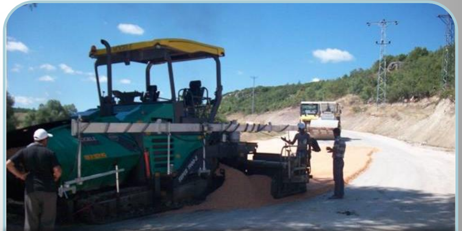
Gölpark Yol Çalışması
