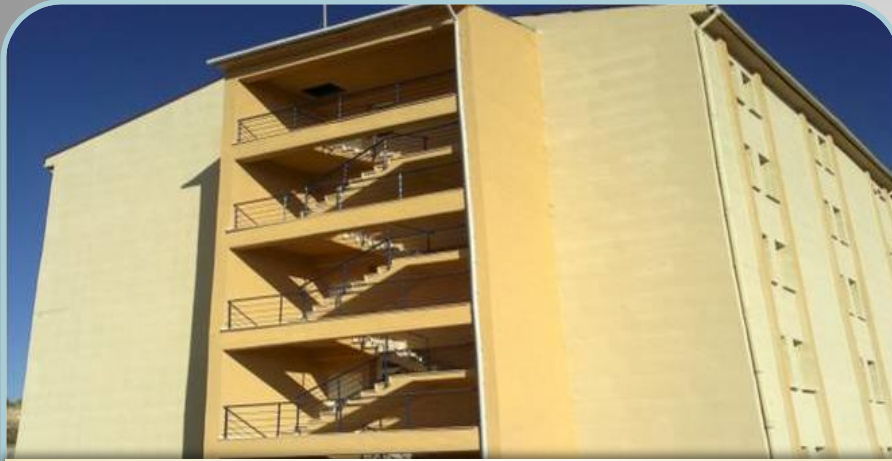
Bilecik Polis Mesleki Eğitim Merkezi Yangın Merdiveni Yapım İşi
