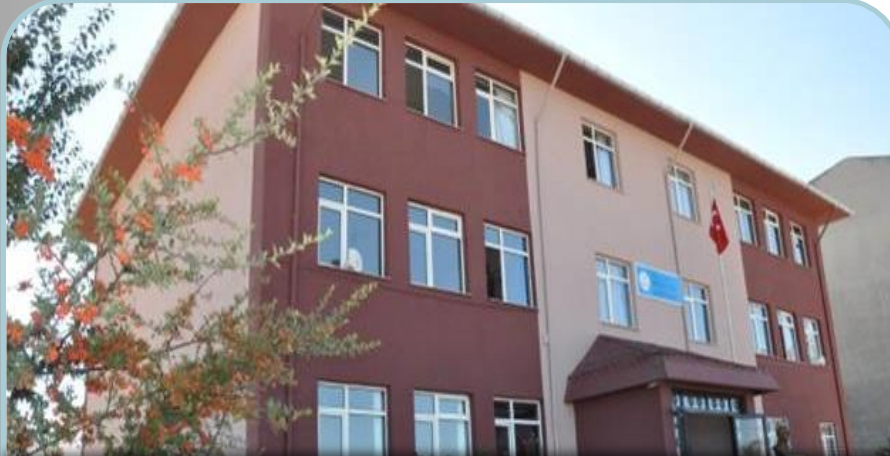
Pazaryeri 5 Eylül İlköğretim Okulu Dış cephe Mantolama ve Islak Mekan Tadilatı
