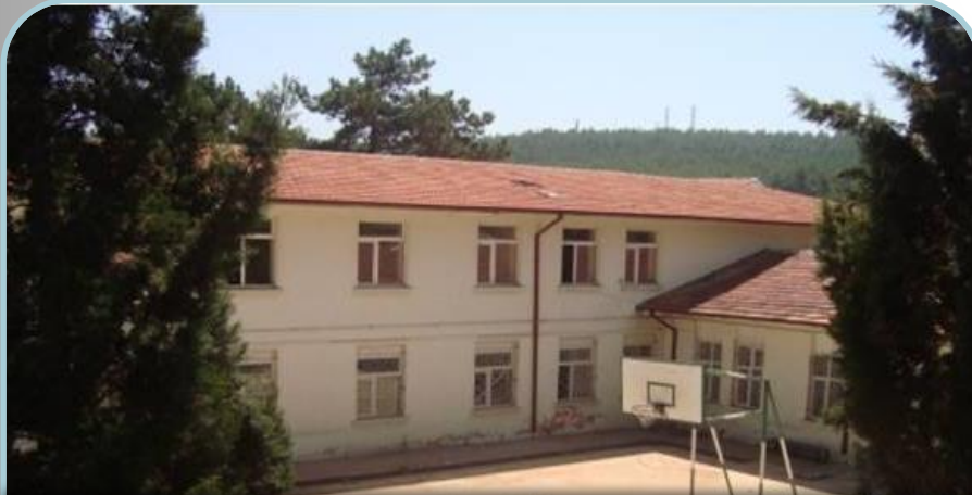
Bilecik Endüstri Meslek Lisesi Çatı Onarımı ve Islak Mekan Tadilatları
