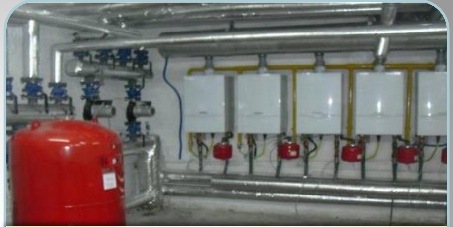
Bozüyük Atatürk İlköğretim Okulu Doğalgaz Dönüşüm İşi
