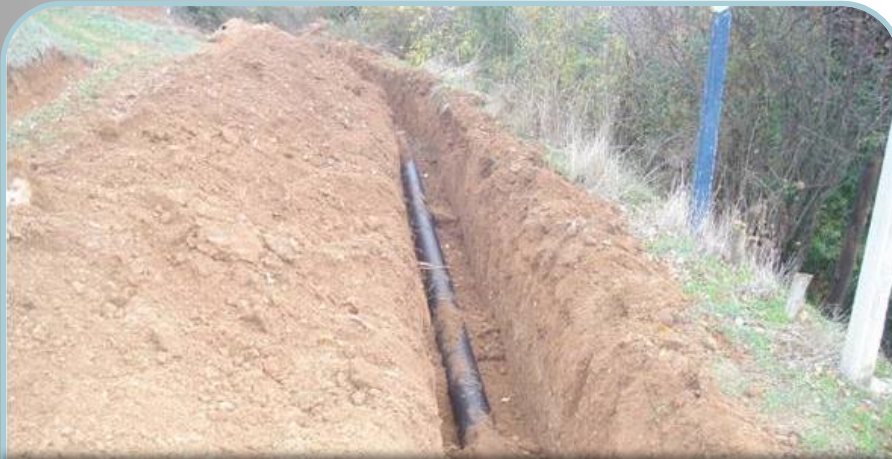
Osmaneli-Günüören Köyü Kanalizasyon Çalışması
