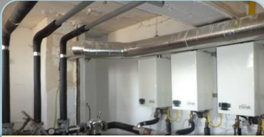
Bilecik Merkez M. Akif Ersoy İlköğretim Okulu Doğalgaz Dönüşüm İşi
