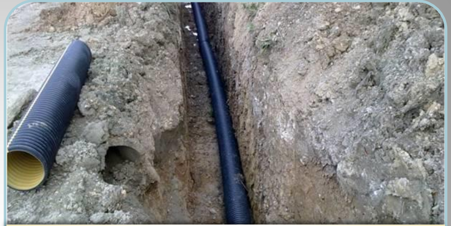
İnhisar-Akköy-Kargılı Kanalizasyon Çalışması
