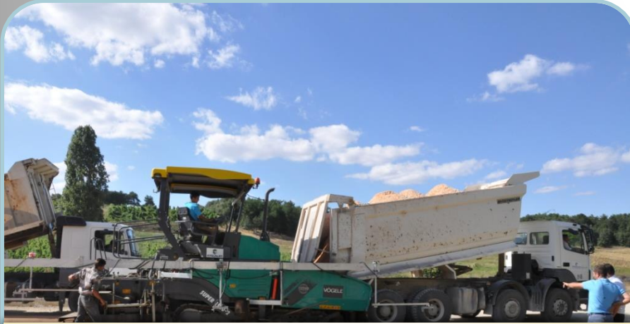
Pelitözü Gölpark Yol Çalışmaları
