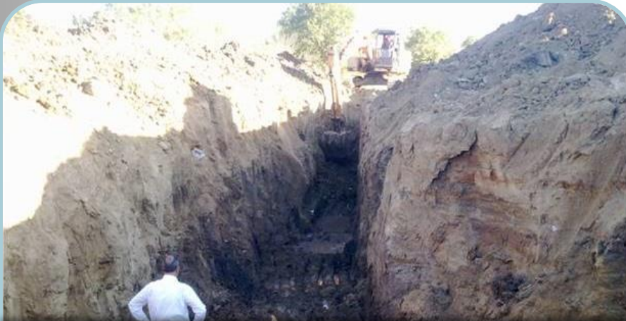
Bozüyük-Kızıltepe Köyü Drenaj Çalışması
