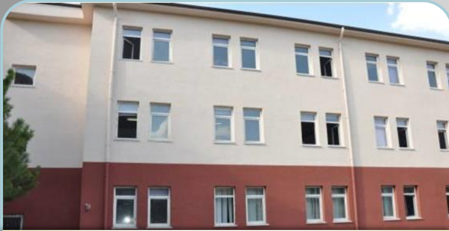
Bozüyük Ticaret Meslek Lisesi Dış cephe Mantolama İşi
