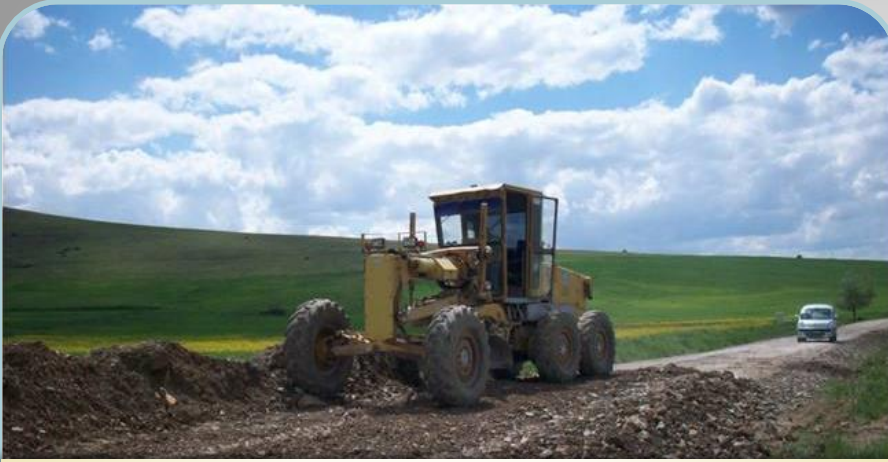
Söğüt-Ortaca-Yeşilyurt Yol Çalışması
