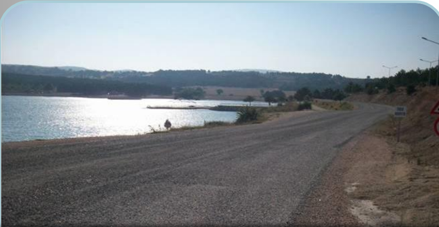
Gölpark Yol Çalışması
