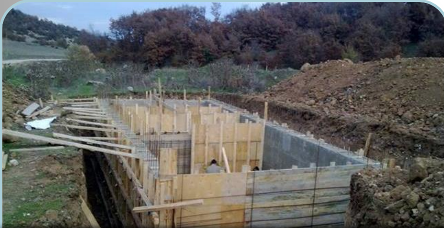
Bozüyük-Çaydere Fosseptik İnşaatı
