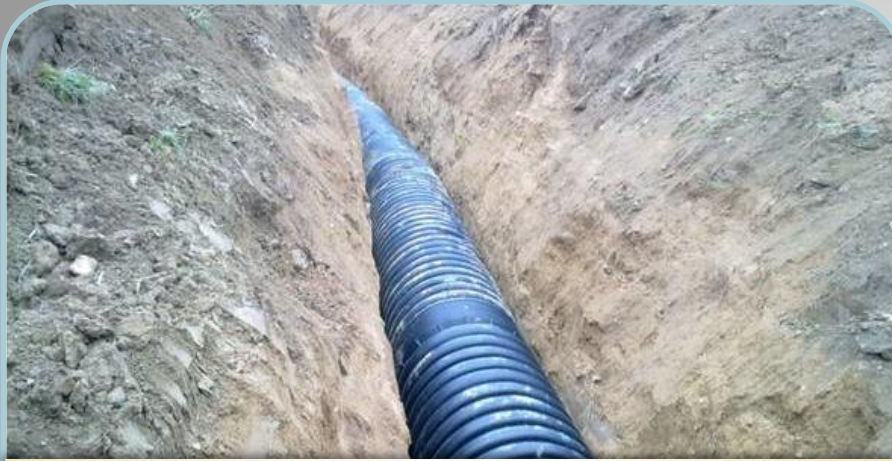
Yenipazar-Kuşça Köyü Kanalizasyon Çalışması
